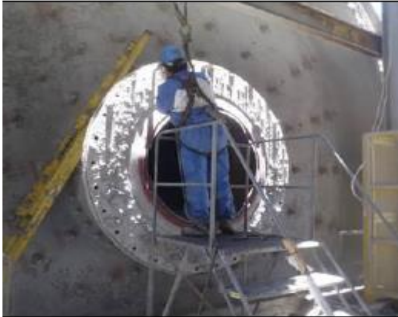
Figura 14. Desmontaje de Sello Sandwich
