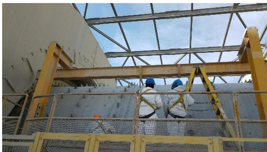
Figura 36. Retiro de tuercas, arandelas, gomas de arandelas y botado de pernos
