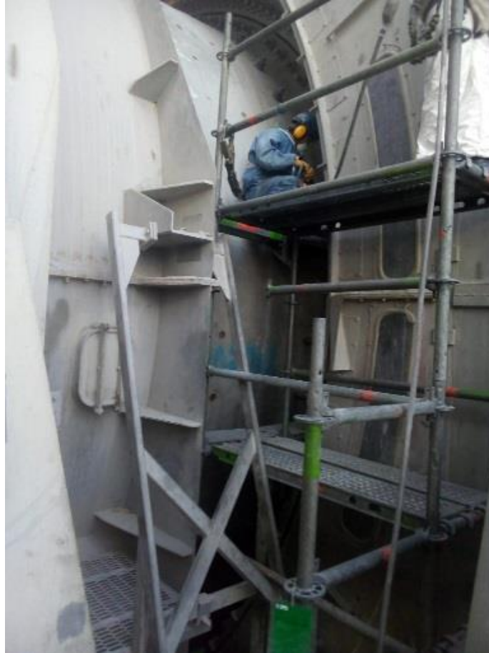
Figura 30. Plataformas usadas durante el proceso del cambio de revestimientos del molino de bolas
