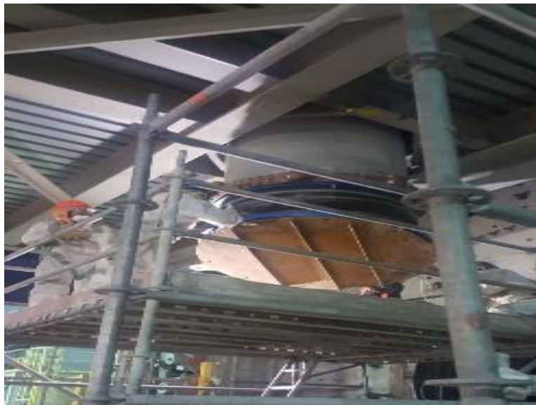
Figura 13. Instalación de Tapa
