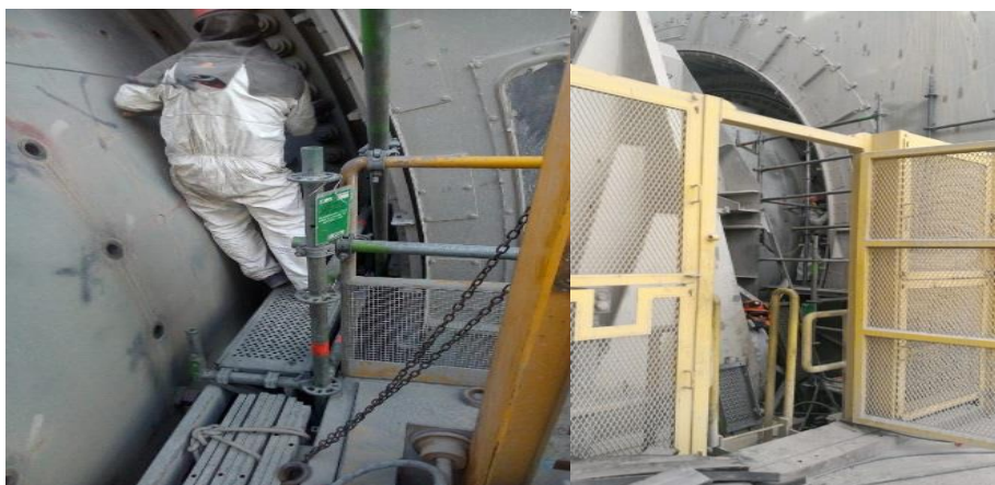
Figura 31. Personal laborando durante el proceso del cambio de revestimientos del molino de bolas
