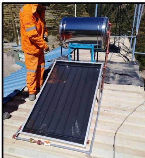
*Figura 48.* Instalación de una terma solar Sol y Vida de 90L.
