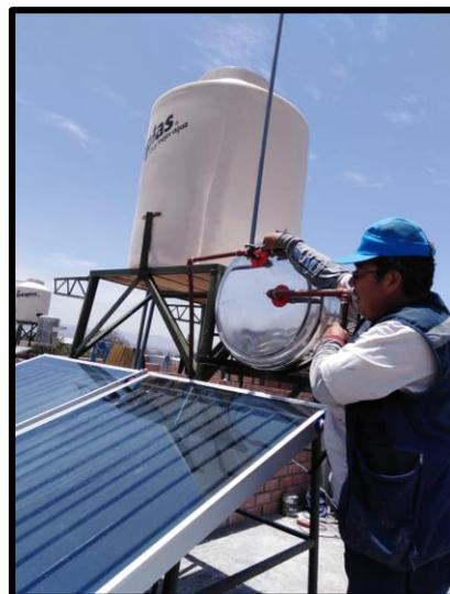
*Figura 47.* Instalación de una terma solar Sol y Vida de doble panel.
