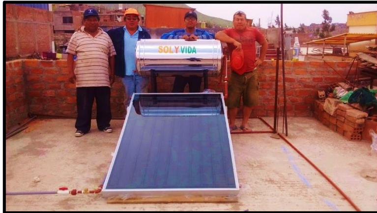
*Figura 46.* Instalación de una terma solar Sol y Vida de 120L.
