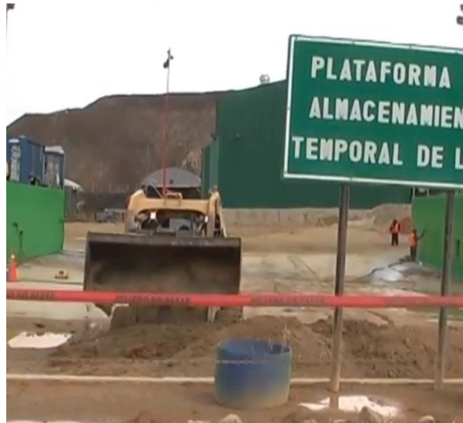
Ilustración 37: Limpieza de la plataforma
