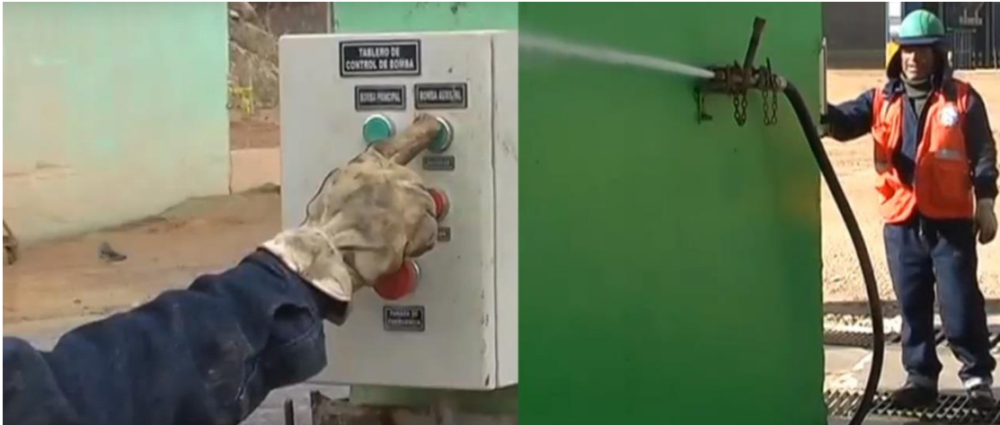
Ilustración 18: Bomba eléctrica y bomba hotsy
