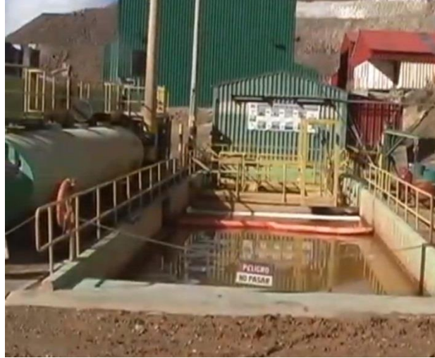
Ilustración 39: Poza sedimentadora de lodo
