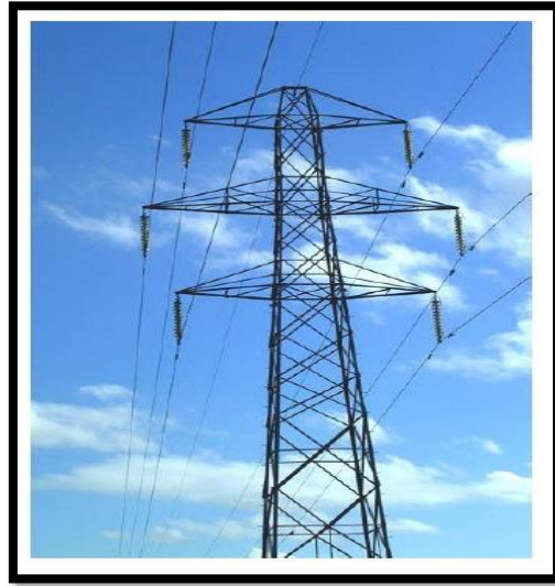
Figura 13: Torre de suspensión de doble terna.
