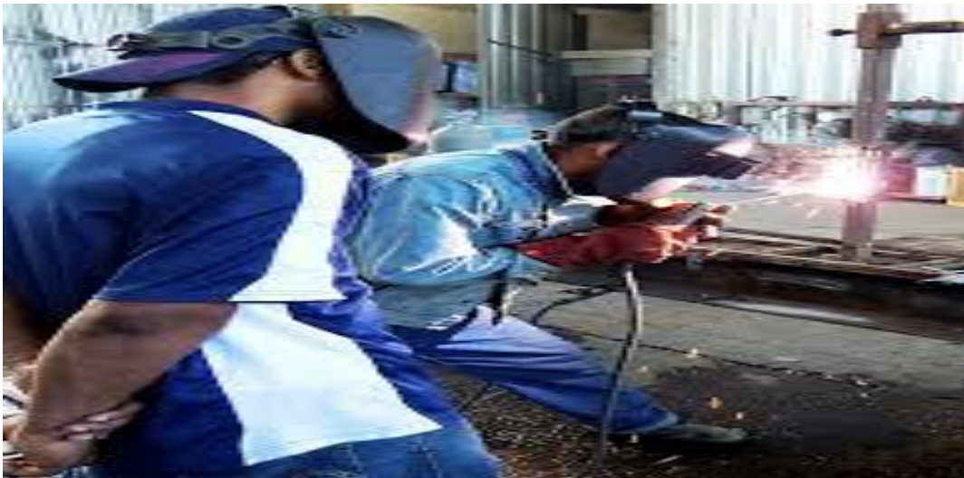
Figura 29. Armado y soldeo de planchas
