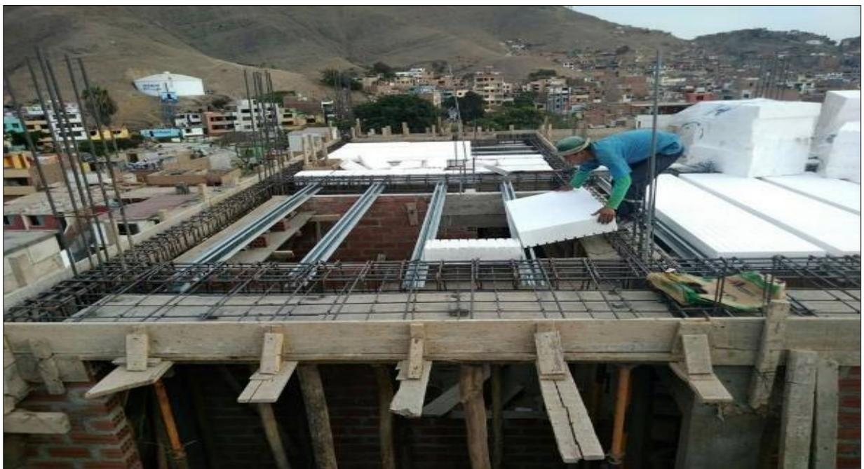
Figura 65. Instalación de losa aligerada con Vigacero. Tomado de "Manual técnico para el uso de placas colaborantes para losas de entrepiso", por Acero Deck. Lima, 2009.
