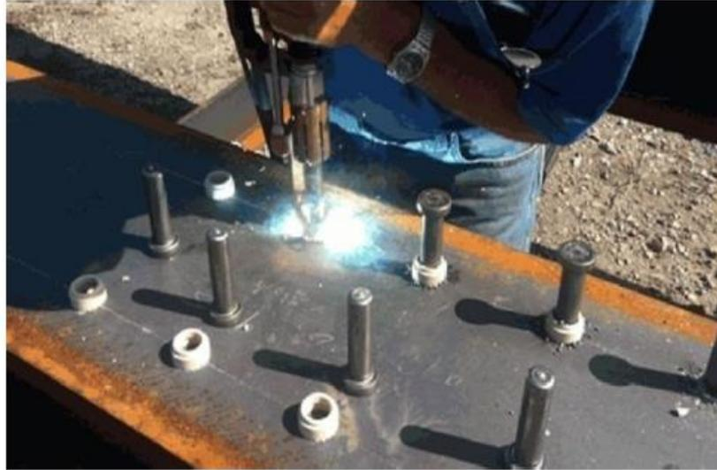
*Figura 14.* Colocación de pernos soldados sobre el ala de una viga de acero. Tomado de “Diseño sísmoresistente de construcciones de acero”, por F. Crisafulli. Santiago de Chile: Asociación Latinoamericana de Acero (ACERO), 2018.
