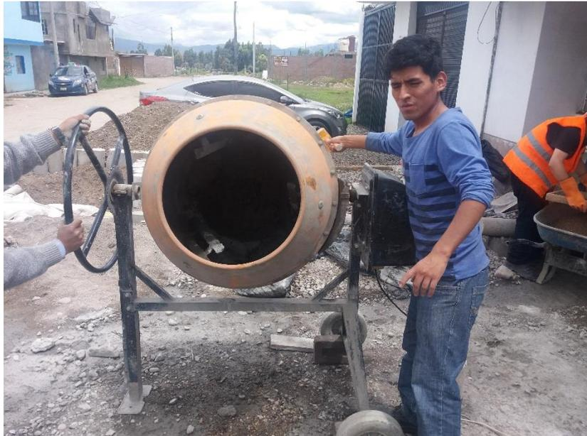
**Figura 57. Preparado de concreto convencional compuesto por cemento, arena y agua**
