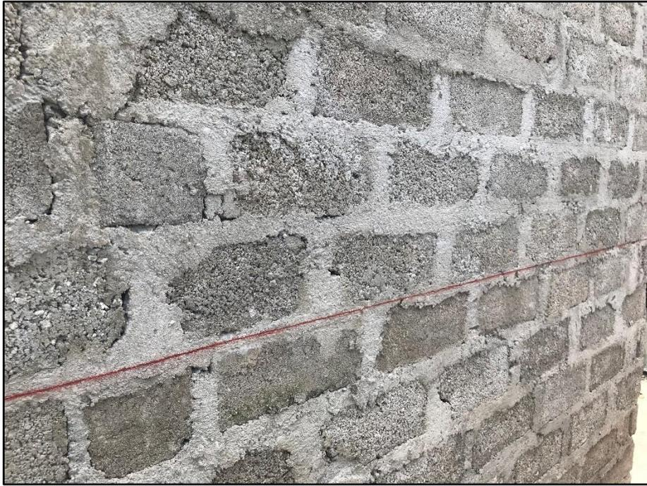
**Figura 109. Juntas de mortero de 2 a 2.5 cm**
