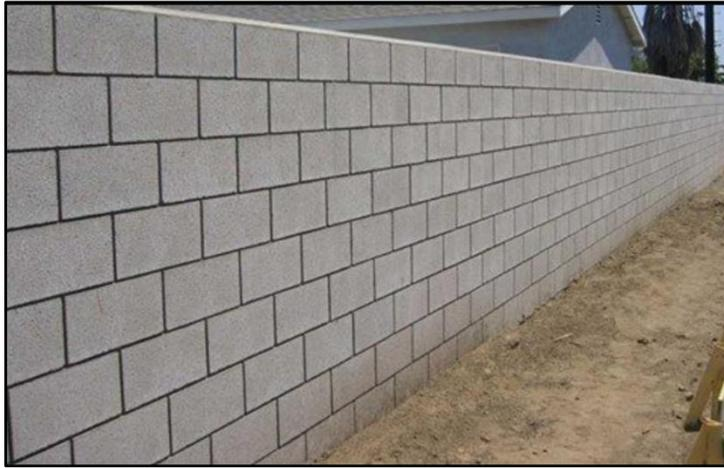
**Figura 25. Cerco perimétrico con bloques de concreto**
