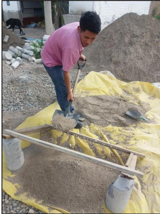
**Figura 33. Tamizado de agregado fino separando partículas mayores a 3/8"**
