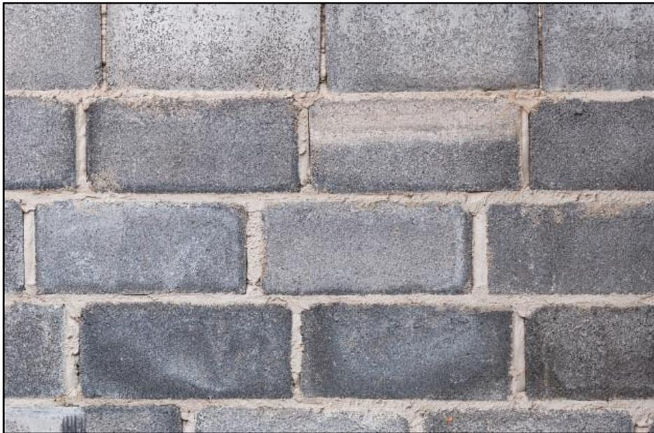
**Figura 110. Correcto asentado de unidades de concreto, con juntas menores a 1.5 cm**
