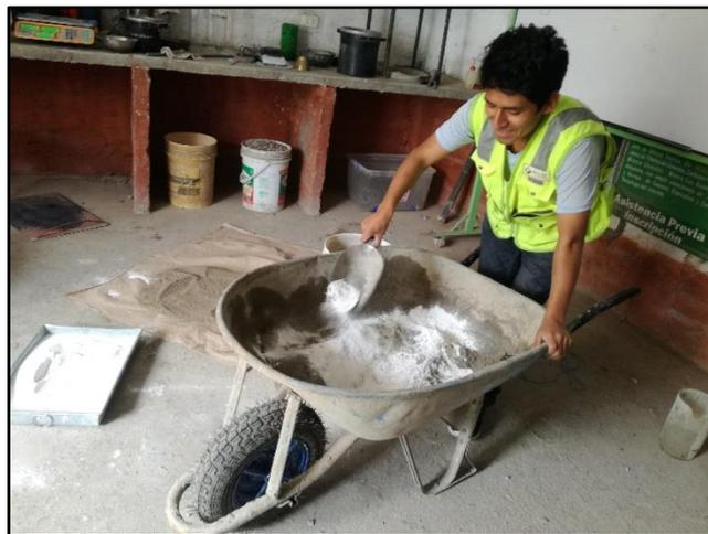
**Figura 85. Preparado de mortero para asentado de ladrillos**
