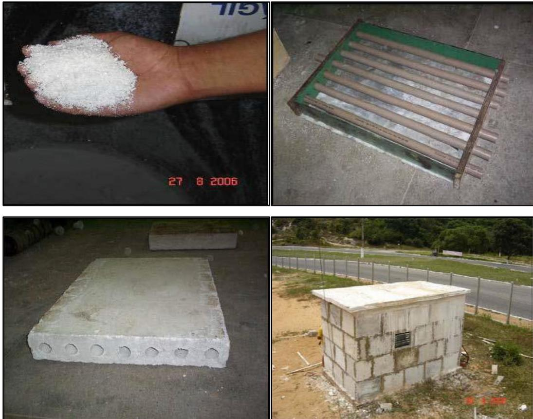
**Figura 8. Unidad Habitacional construida con panel de concreto con poliestireno expandido**
