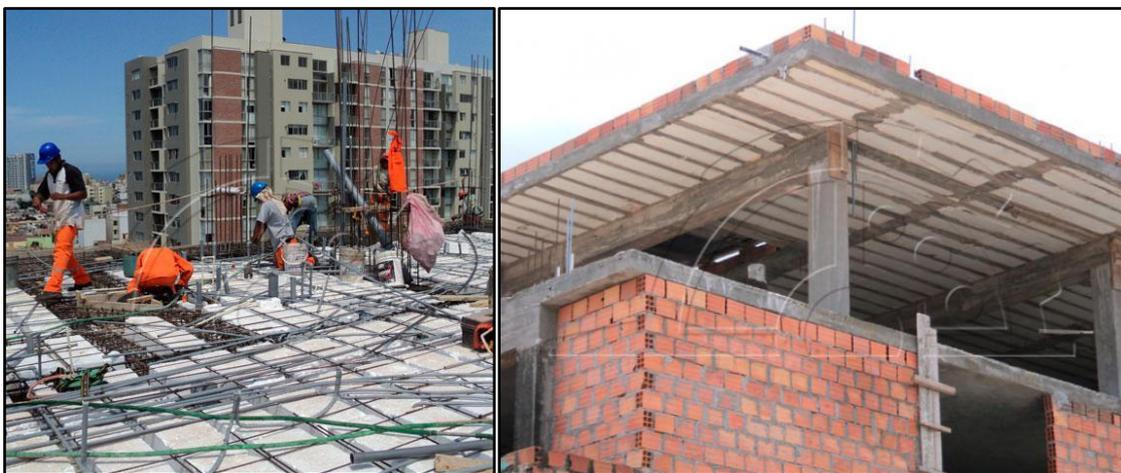
**Figura 11. Bloques de poliestireno expandido utilizado en losas aligeradas**
