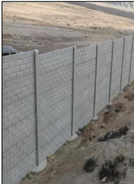
**Figura 24. Cerco perimétrico con unidades de concreto**
