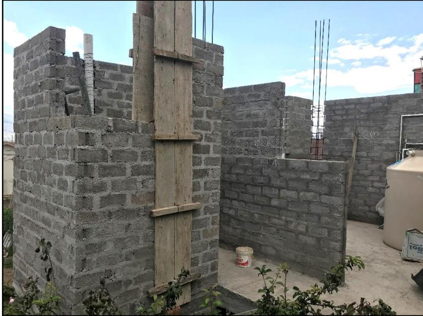
**Figura 105. Construcción de muro de albañilería con unidades de concreto con EPS**
