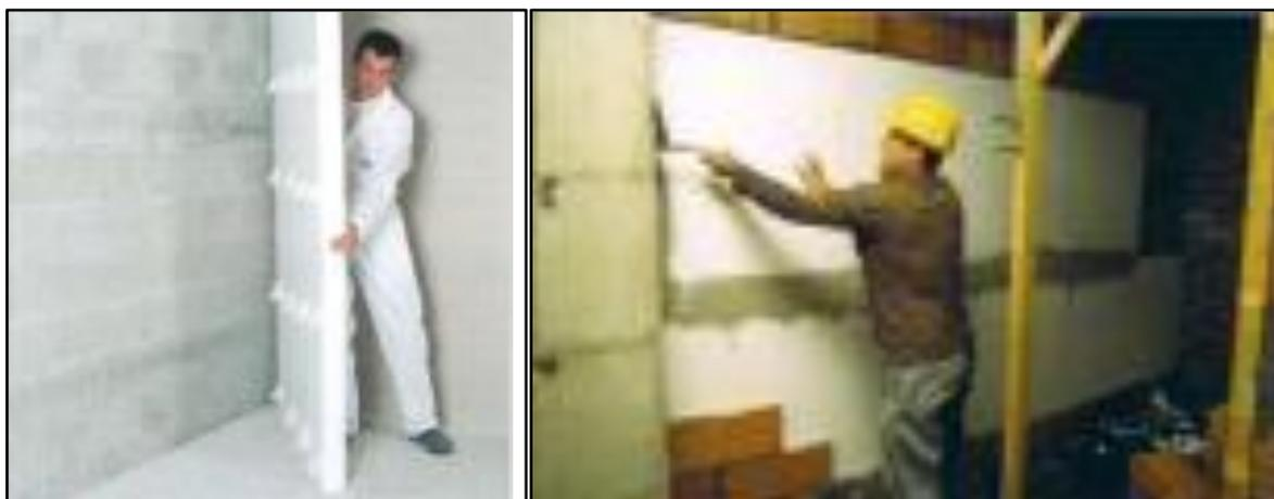
**Figura 9. Fachadas utilizando paneles de EPS y yeso laminado**
