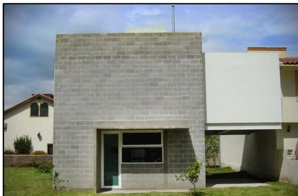
*Figura 22. Construcción de viviendas con ladrillos de concreto
