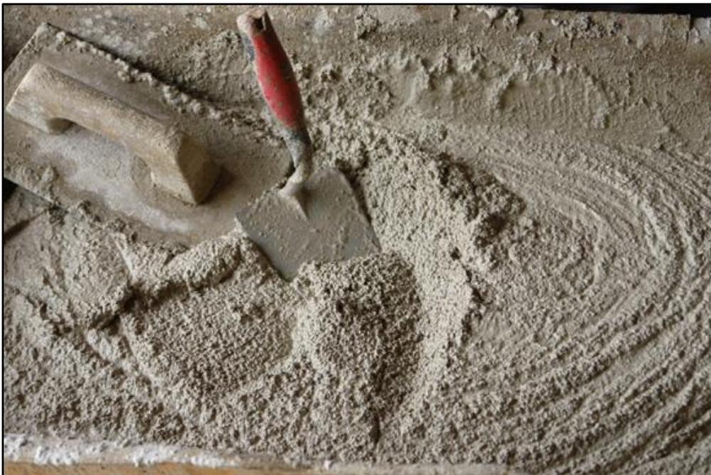
***Figura 107. Preparación del mortero con cal***
