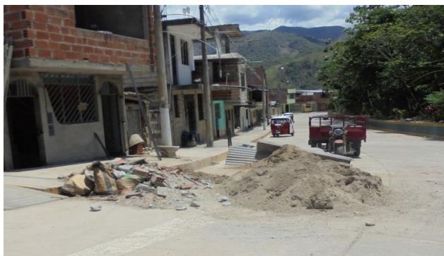
Figura N°22. Disposición de los residuos de construcción afuera de la vivienda.
