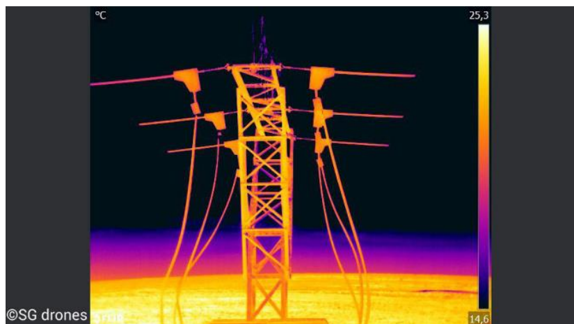
Figura 33. Inspección técnica con cámara termográfica, mediante dron de una torre de alta tensión.
