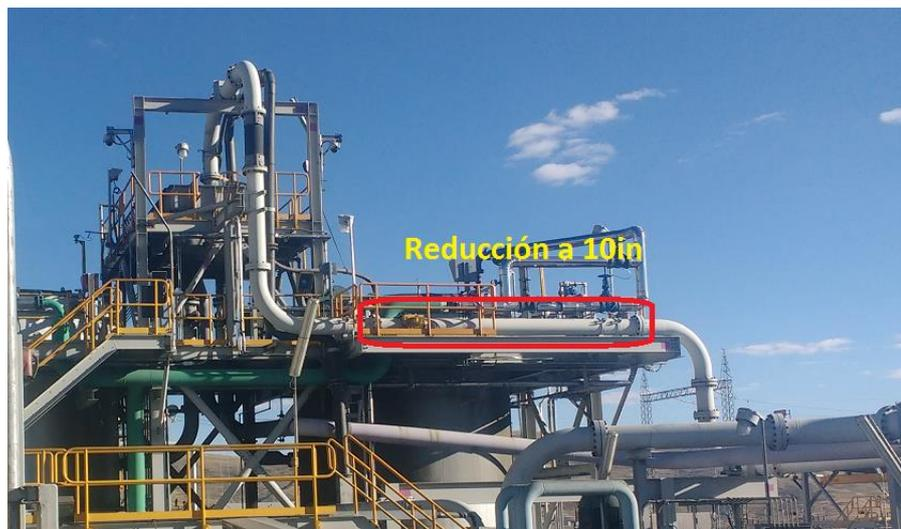
Figura 50. Ubicación de cambio de tubería de 12" a 10"
